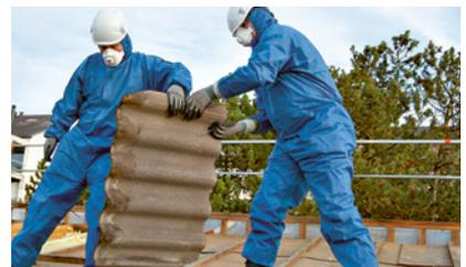
**2** Lors des travaux de démontage, les plaques de fibrociment contenant de l'amiante doivent être laissées en l'état.
